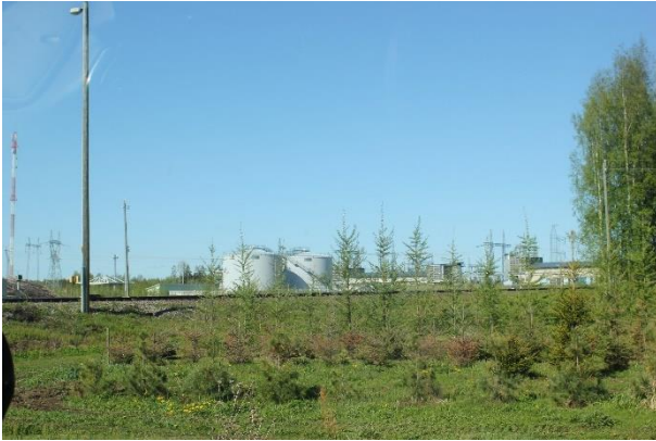
Kuva 22. Huutokosken sähkölaitos. Näkymä Rantatieltä, laitoksesta itään.
