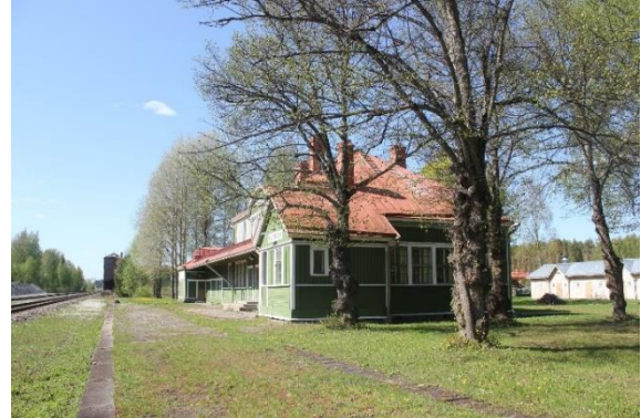
Kuva 6. Huutokosken vanha asemarakennus. Taustalla vasemmalla näkyy vesitorni ja kaukana junaradan aukon kohdalla voimalinjan pylväs. Oikealla on asema-alueeseen kuuluva suojeltu liiterirakennus.
